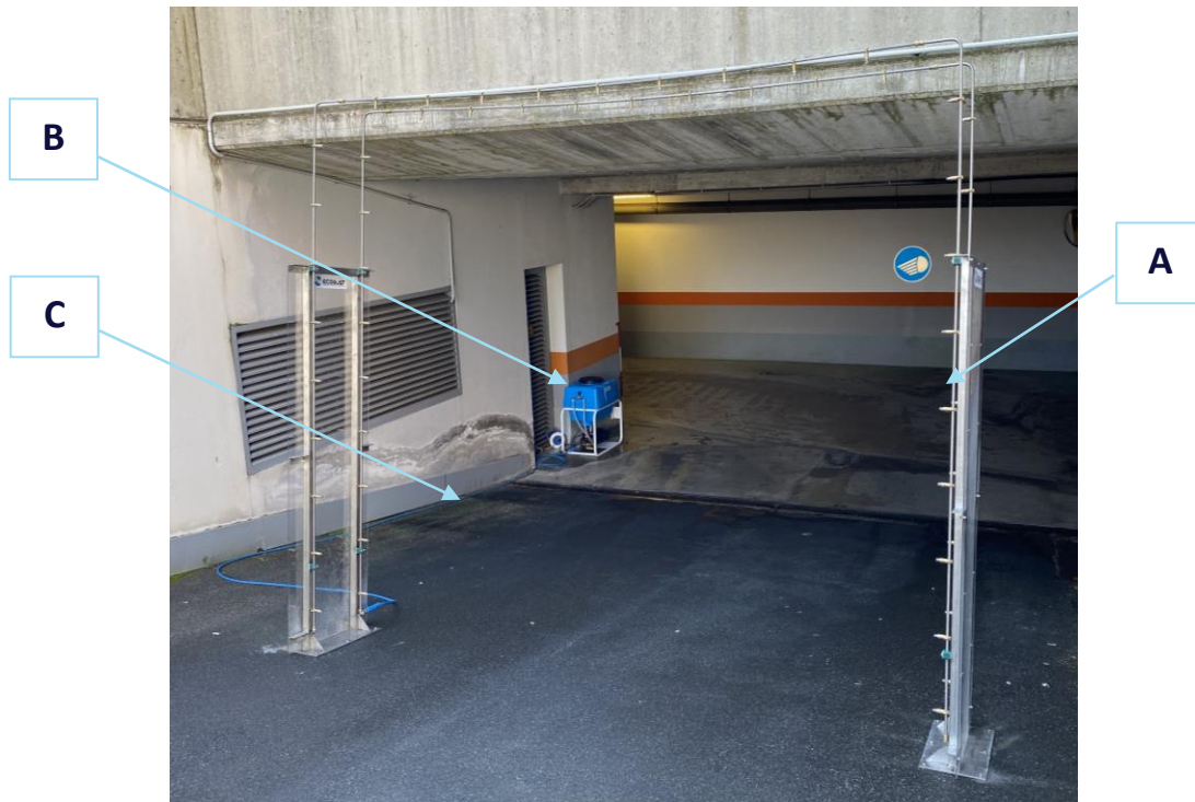
Imagen 2-1. Conjunto de Arco de nebulización
